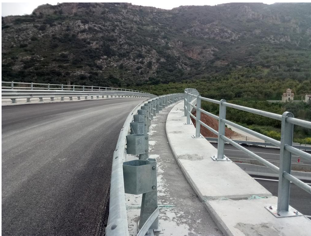
A223 – Αντικατάσταση στηθαίων ασφαλείας
