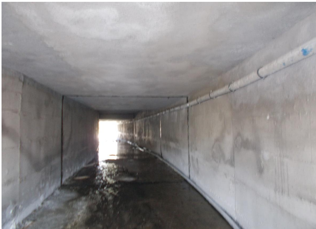
Εργασίες συντήρησης υφιστάμενου τεχνικού S050
