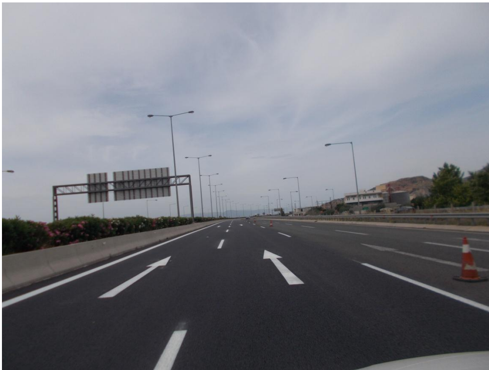
Εργασίες οδοσήμανσης χ.θ. 40+050 έως 42+550
