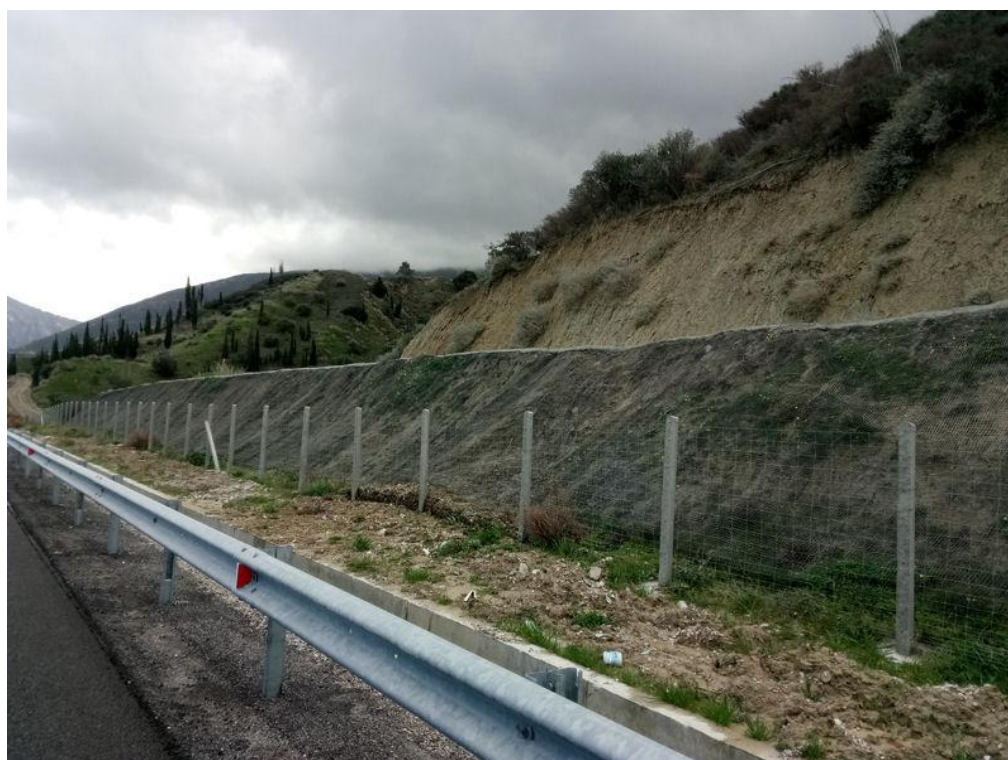
Υφιστάμενο πρανές χ.θ. 44+170 – 44+230 – τοποθέτηση πλέγματος
